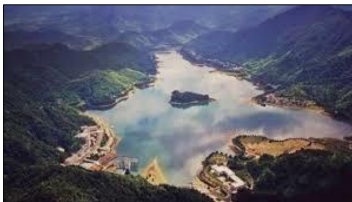
Fig. 6.11 -Usina Hidrelétrica Reversível de Guangzhou
