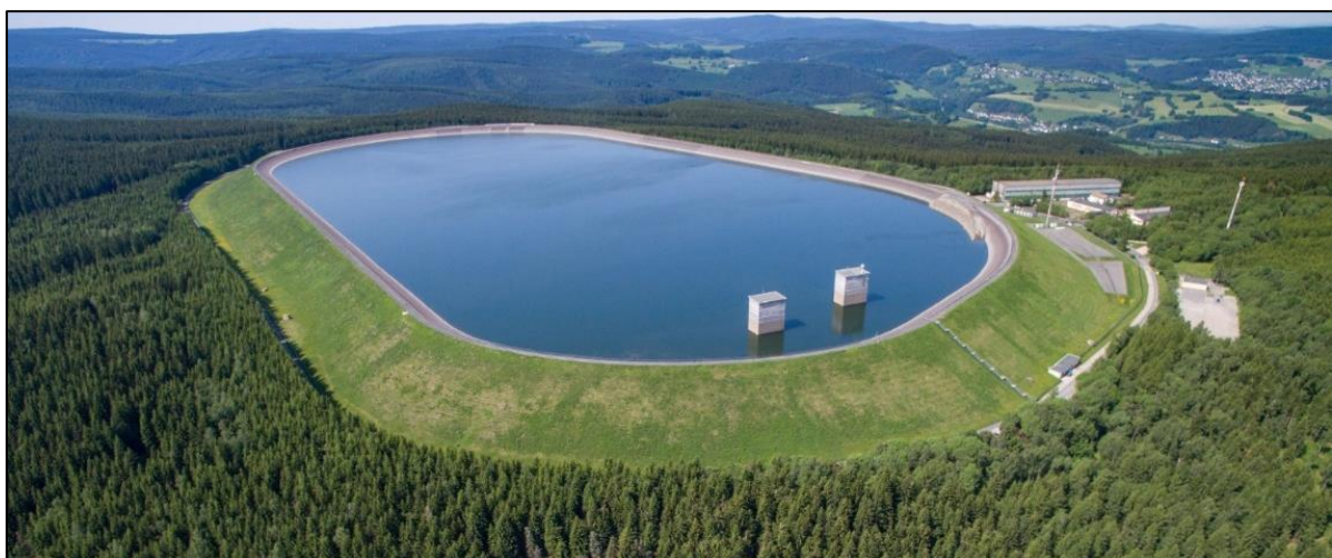
Fig. 4.14 - Usina reversível de Markersbach
