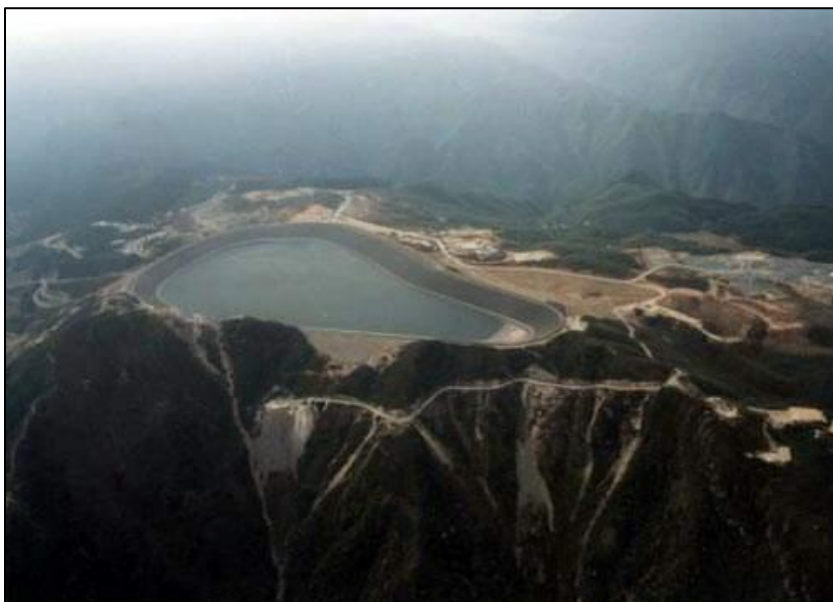
Fig. 6.13 - Usina Hidrelétrica Reversível de Guangdong
