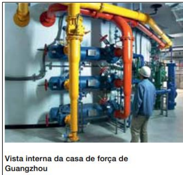
Fig. 6.12 -Usina Hidrelétrica Reversível de Guangzhou
