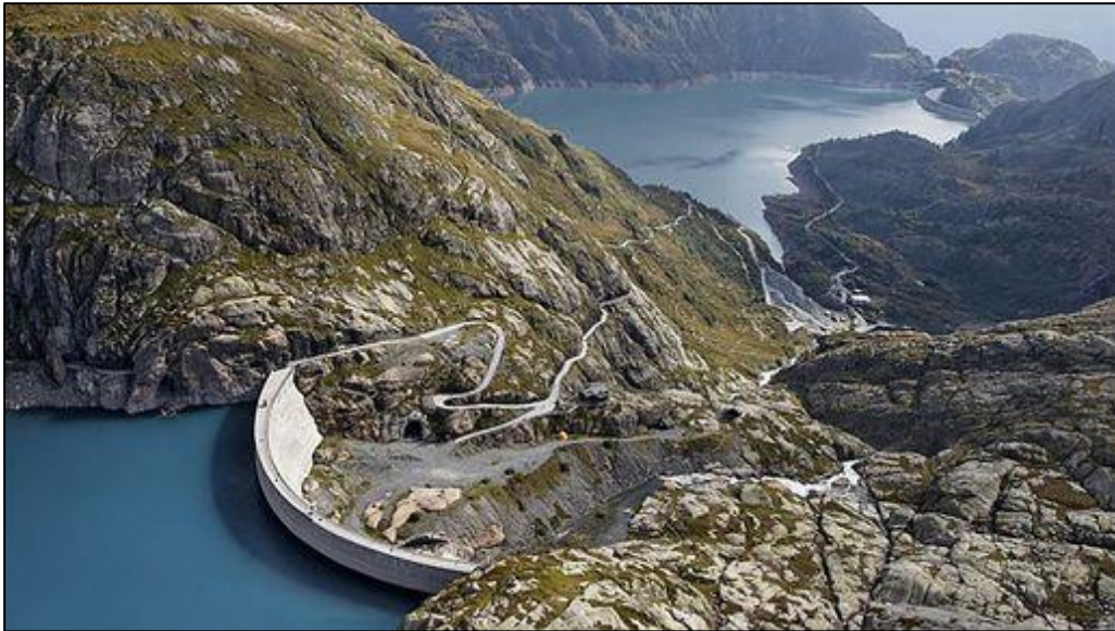
Fig. 3.10 – Lagos superior e inferior da usina Nant de Drance
